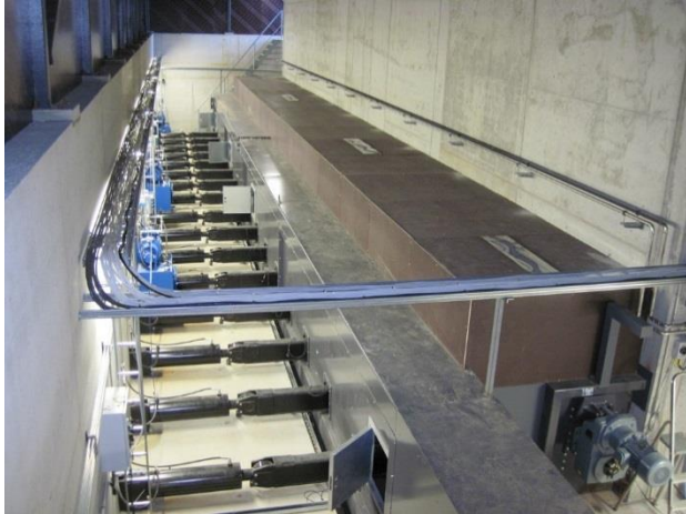
Polttoaineen syöttölaitteet: tankopurkaimien sylinterit, polttoainekuljetin ja repijätelät.
