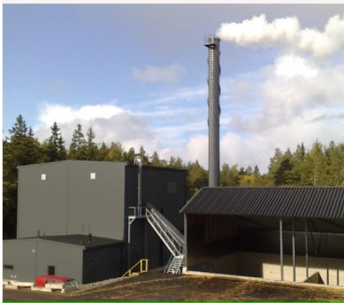
Pansio, Laka 5 + 7 MW
