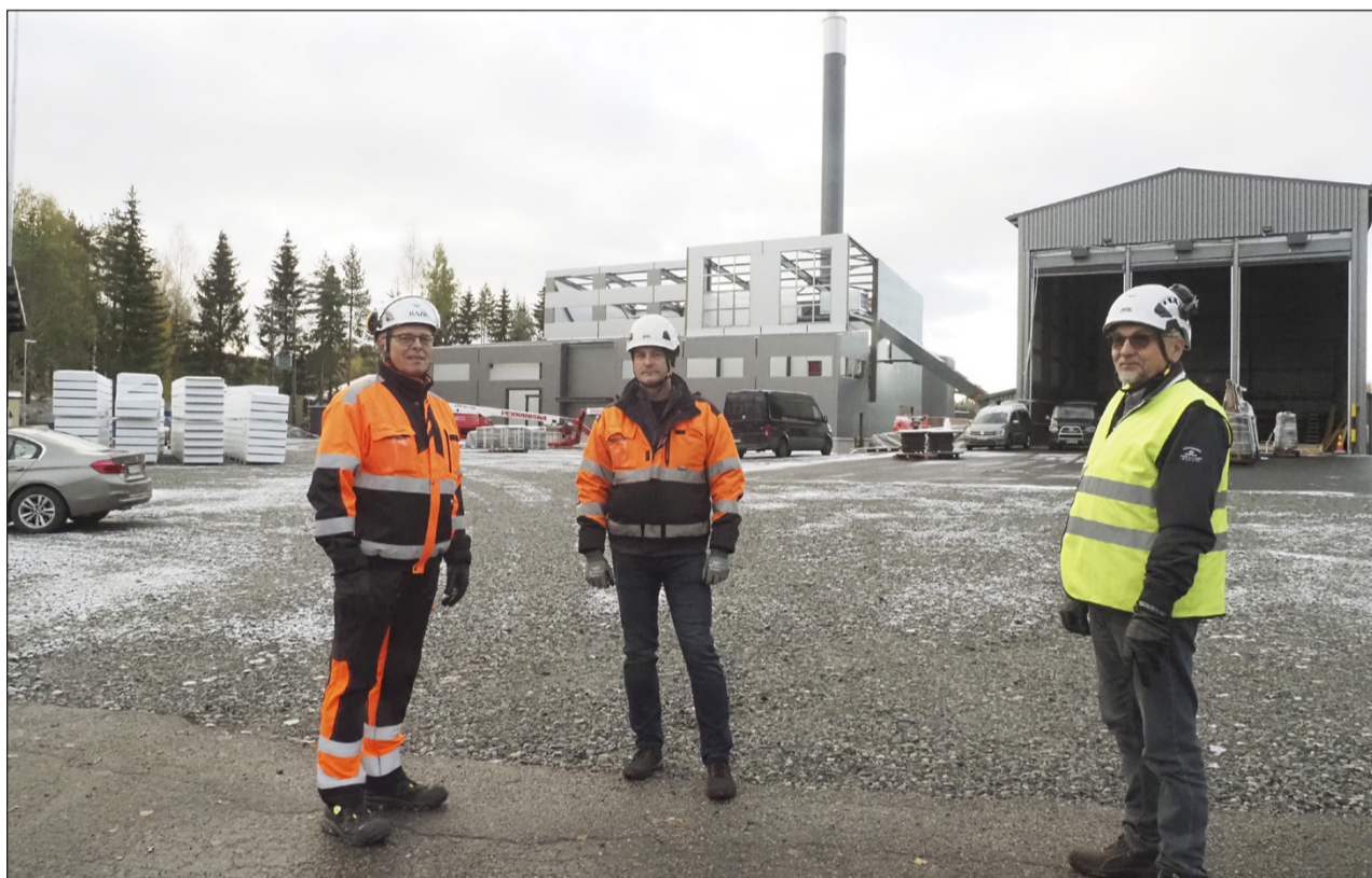
Harjakorkeuteen edennyttä Kiteen Lämpö Oy:n rakennustyömaata esittelivät lämpöyhtiön toimitusjohtaja Pekka K. Vatanen, Laatukattila Oy:n toimitusjohtaja Markku Lampinen ja Kiteen Lämmön hallituksen puheenjohtaja Unto Väkeväinen.
