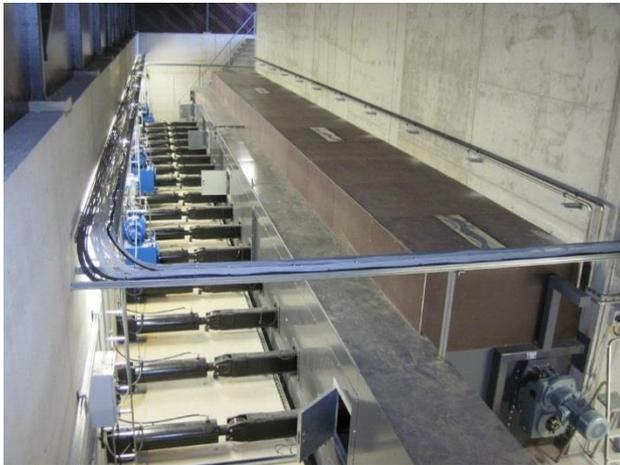
Система подачи топлива: цилиндры толкателей, скребковый транспортер и ворошитель
