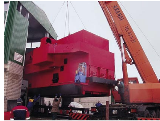
Liettualaisen Svencionysin kaupungin 4,5 MW:n biolämpökeskuksen asennustöitä tehtiin lokakuussa 2003. Toimituksiin sisältyy asennuksen lisäksi myös laitoksen käyttöönotto ja käyttöhenkilökunnan koulutus.
