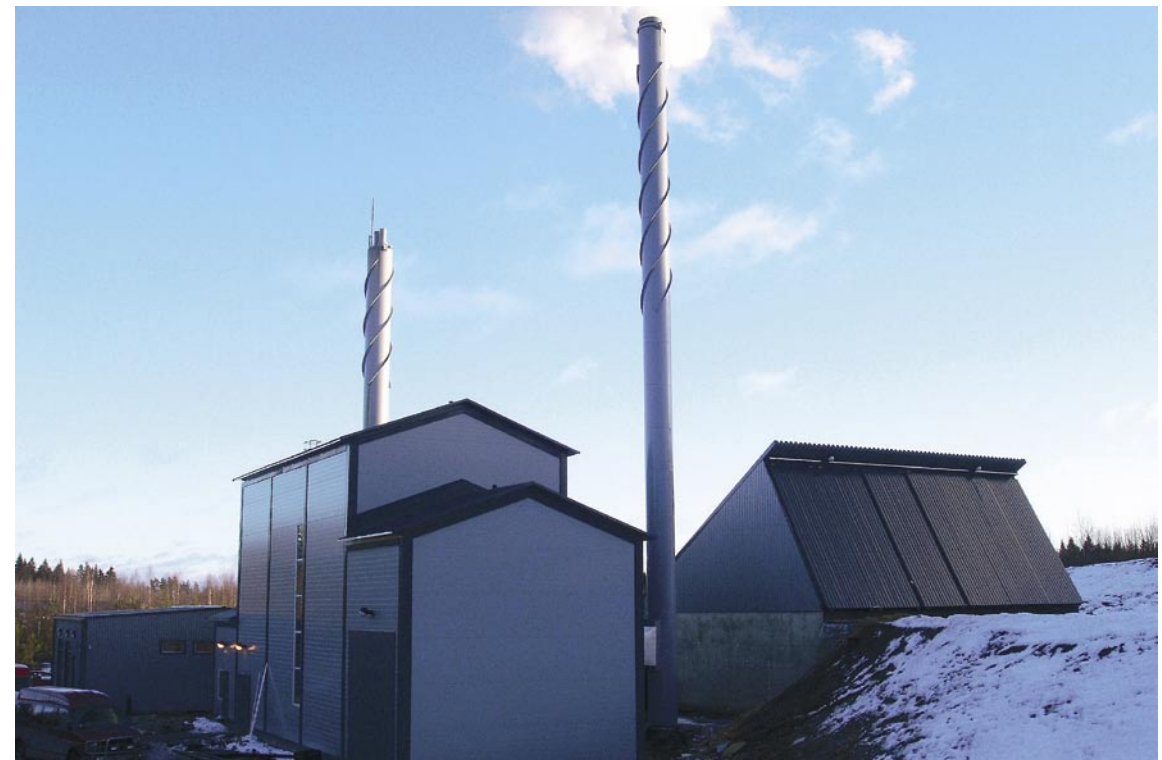
Laatu-kattila Oy:n historian suurin biolämpökeskus käynnistettiin joulukuussa 2005 lämmittämään Loviisan kaupunkia. Kattilan nimellisteho on 7 MW. Paukkupakkasilla mentiin täysillä, ja lämpöä irtosi lähes 9 MW, kun taas kesäheleillä tarvittiin vain noin 0,6 MW:n pikkutehoja.
